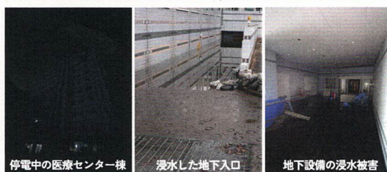
停電中の医療センター棟
